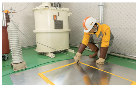
絶縁シート耐電圧試験
